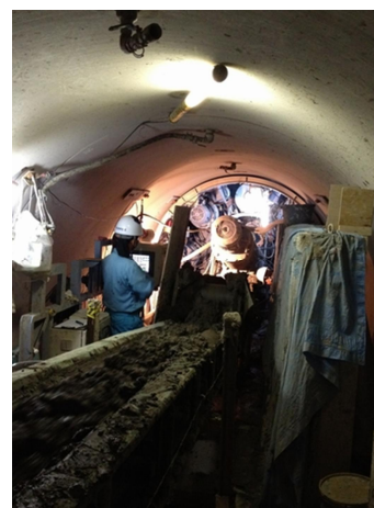
常磐第 1・第 2 貯留管 （施工中の内部）
