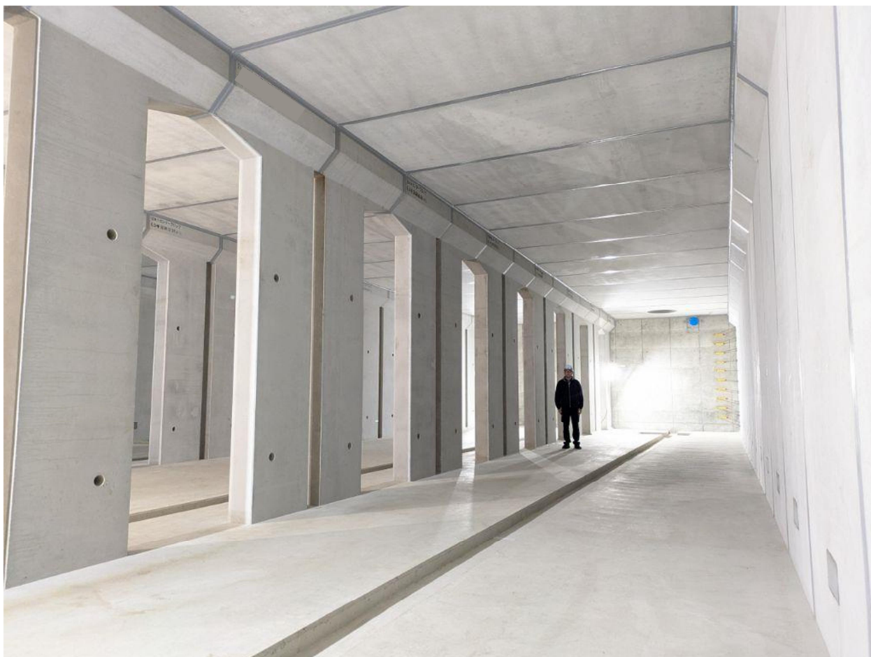
画像：新荘第1排水区雨水貯留施設
