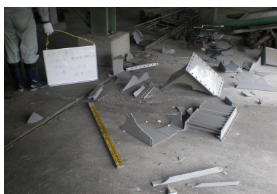
水戸市浄化センターのダクトの破損
