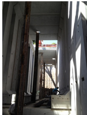
五軒滞水池（施工中の内部）
