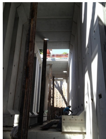
五軒滞水池（施工中の内部）
