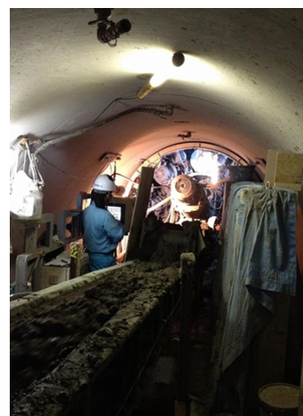
常磐第 1・第 2 貯留管 （施工中の内部）
