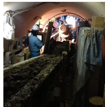
常磐第 1・第 2 貯留管 （施工中の内部）
