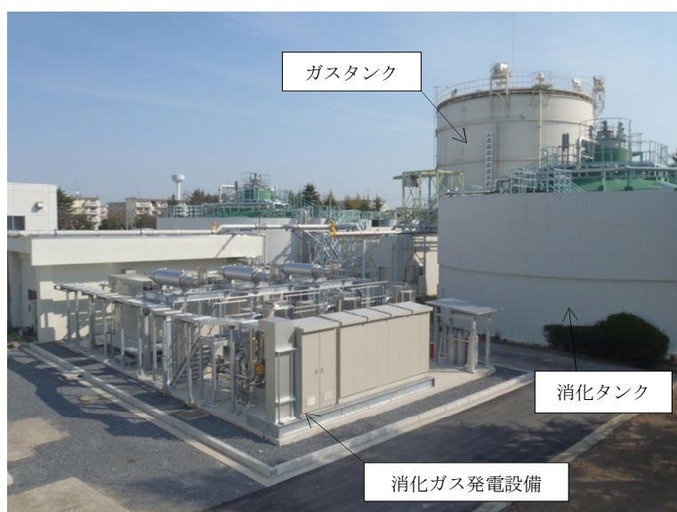
消化ガス発電設備（水戸市浄化センター内）
