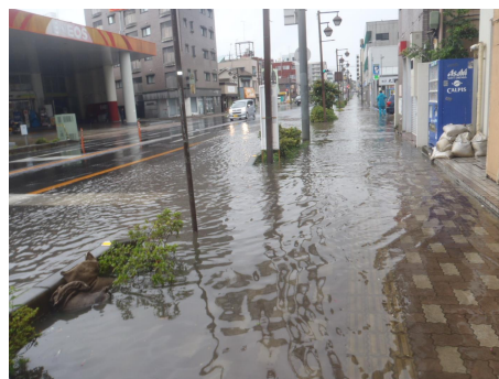
大工町交差点の冠水状況
