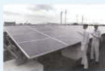
太陽発電設備の検査の様子
