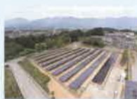
リユース品を使用した発電所
