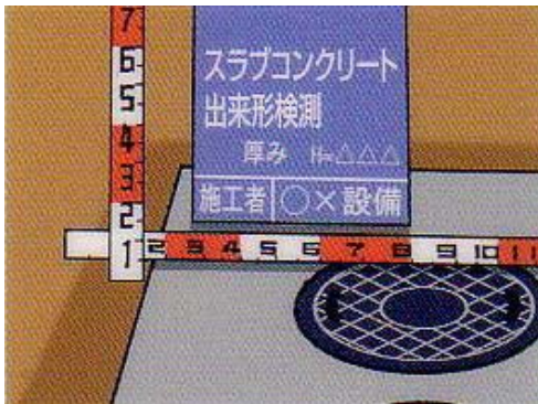
上部スラブコンクリート 厚み確認 H =
