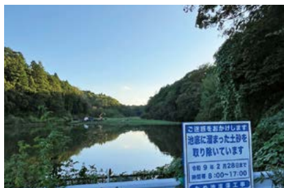
「貯める」対策の工事が進む富士池
