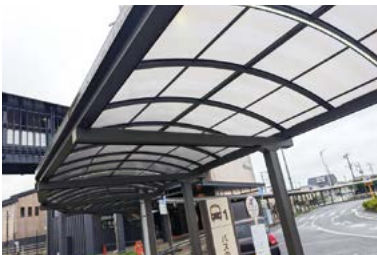
内原駅北口広場に設置されている屋根
