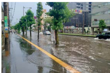
集中豪雨で冠水した市道
