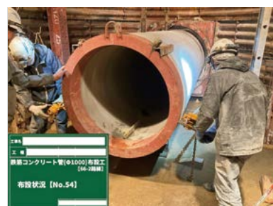
雨水管の施工中の様子
