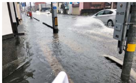
令和3年7月11日に発生した冠水
