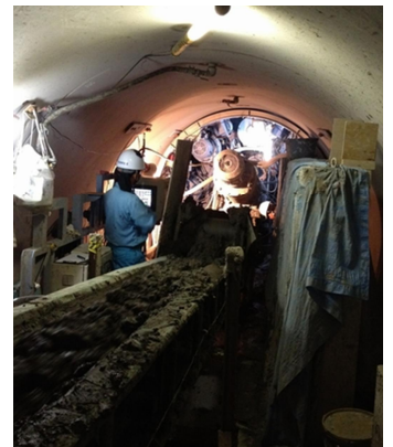
常磐第 1・第 2 貯留管 （施工中の内部）
