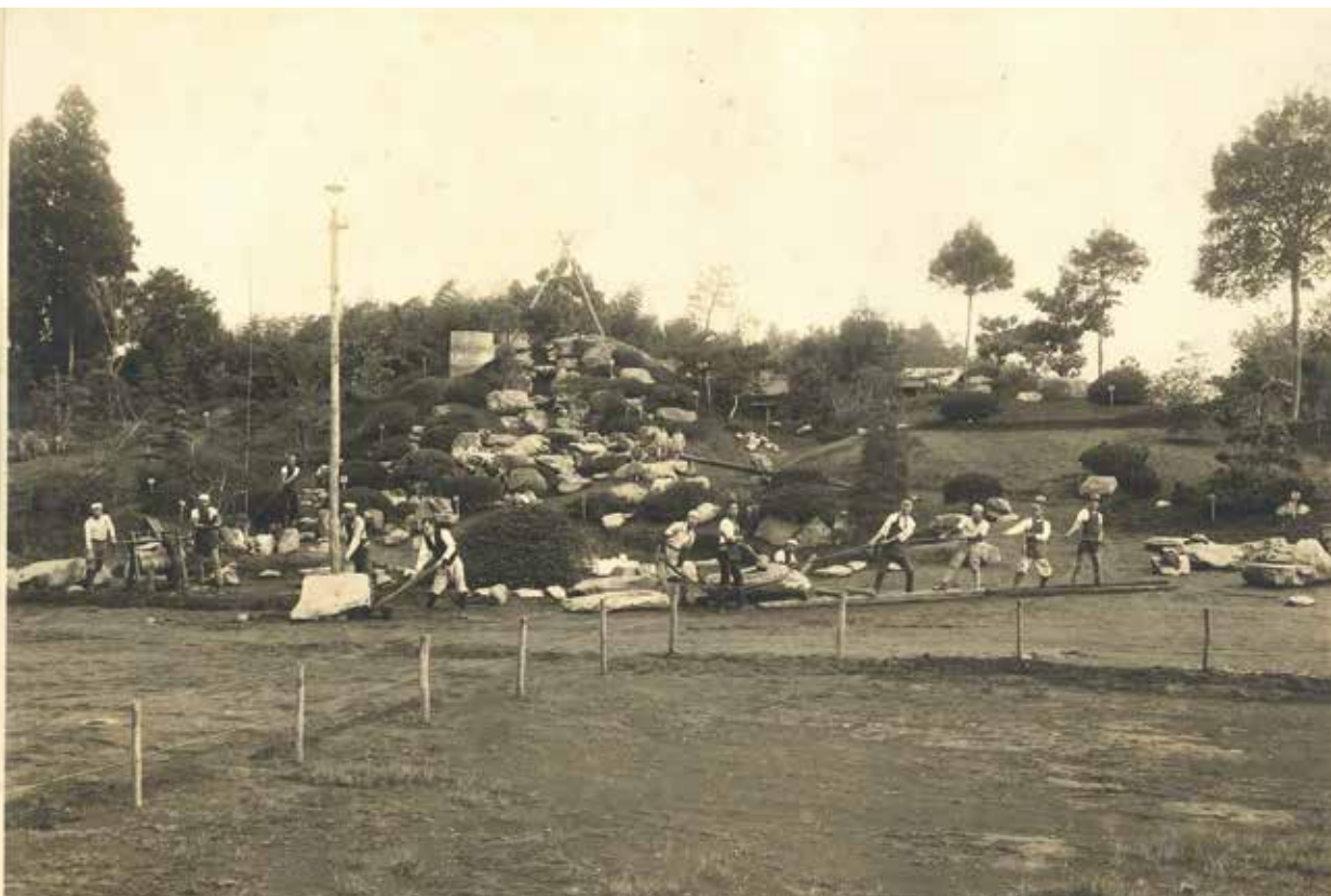
保和苑造成のため土木作業を行う保和苑保存会の人々
