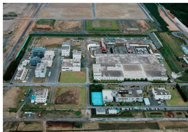
那珂久慈浄化センター
