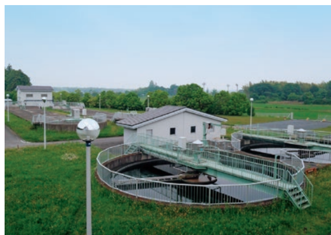
内原浄化センター
