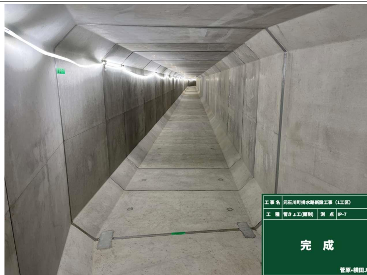
菅原・横田JV 元石川町排水路新設工事(1工区)
