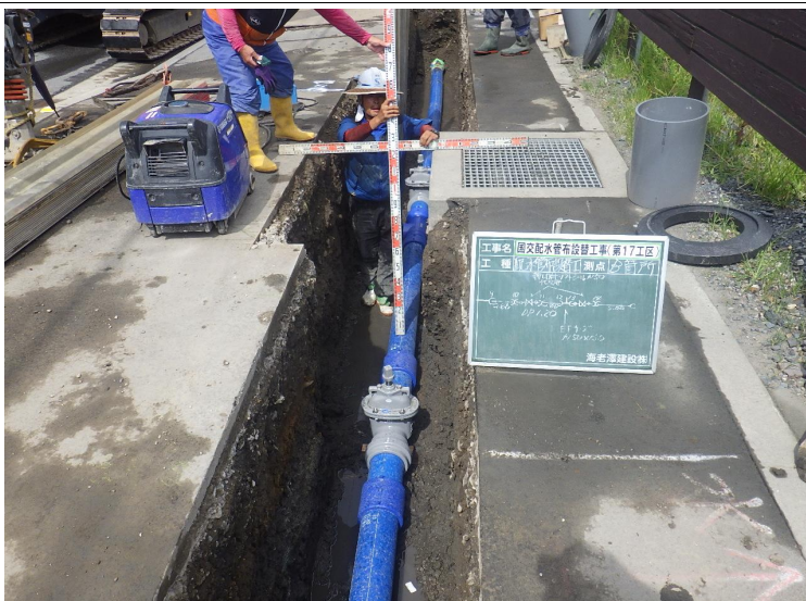
海老澤建設 株式会社 国交配水管布設替工事(第17工区)
