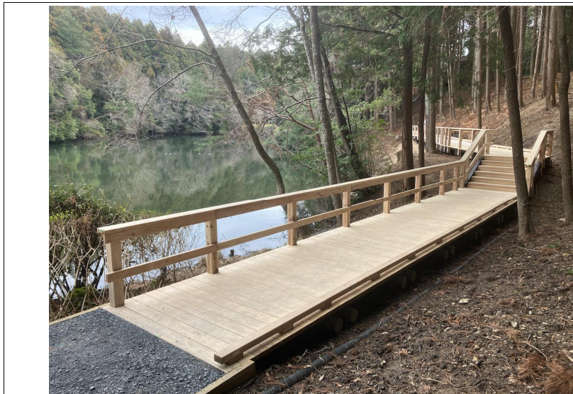
株式会社 タナカ築庭 国補七ツ洞公園木道改築工事
