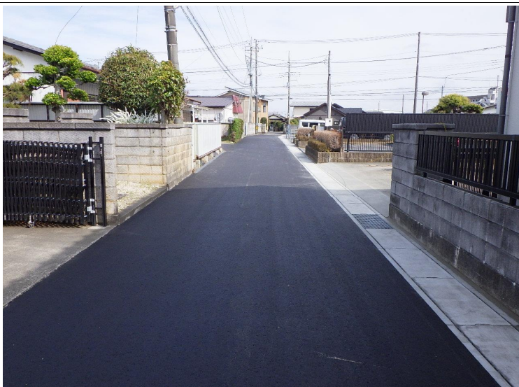
有限会社 城建工業 吉田186号線側溝新設工事
