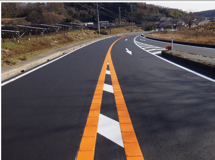
東洋工業 株式会社 幹線市道30号線舗装補修工事
