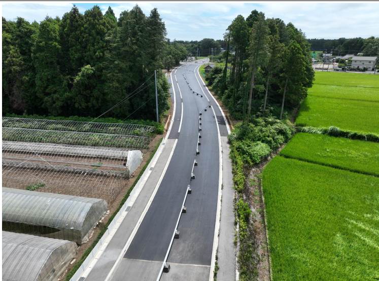
田口建・横田JV 酒門358号線道路改良(5工区)工事
