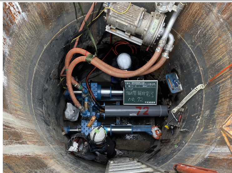
平和建設 株式会社 国補流域関連下水道東水戸処理分区枝線(2-1工区)工事
