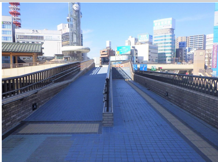
足立・酒井JV 水戸駅北口ペDESTリアンデッキ橋脚補強及びスロープ改修工事
