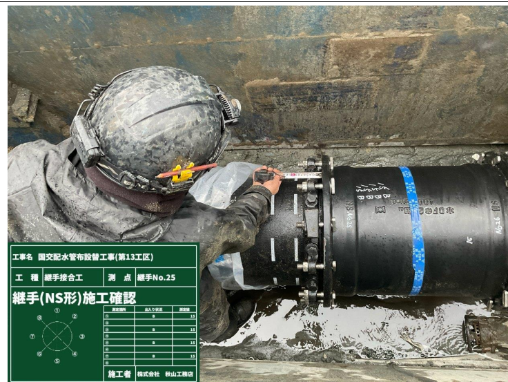
株式会社 秋山工務店 国交配水管布設替工事(第13工区)
