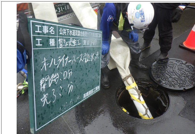
高橋建設工業 株式会社 公共下水道双葉台処理分区枝線改築工事
