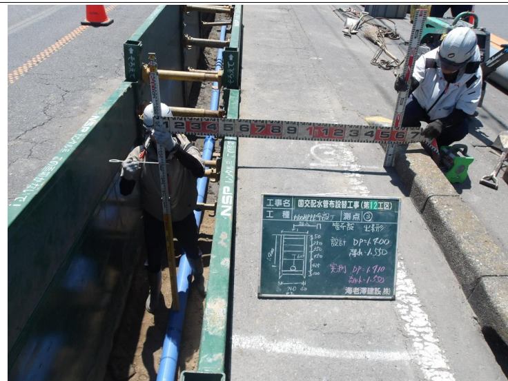
海老澤建設 株式会社 国交配水管布設替工事(第12工区)
