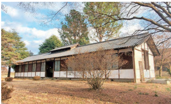
満蒙開拓幹部訓練所 事務棟・講義棟(鯉淵町／市認定建造物)
