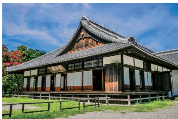
弘道館(茨城県水戸市／国特別史跡)
