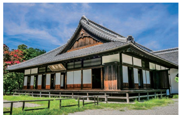
弘道館(茨城県水戸市／国特別史跡)
