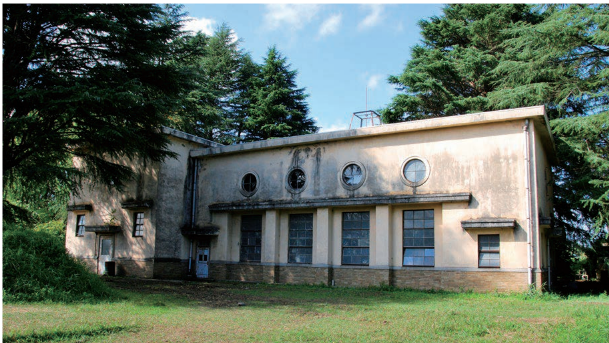
芦山浄水場(渡里町)
