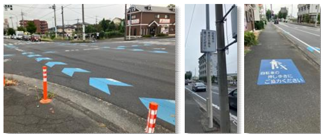
市内の整備状況（左から矢羽根、看板、歩道上表示）
