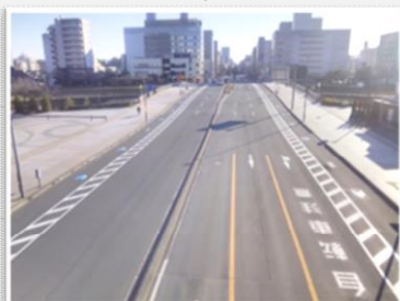
(幹線市道39号線の整備状況)
