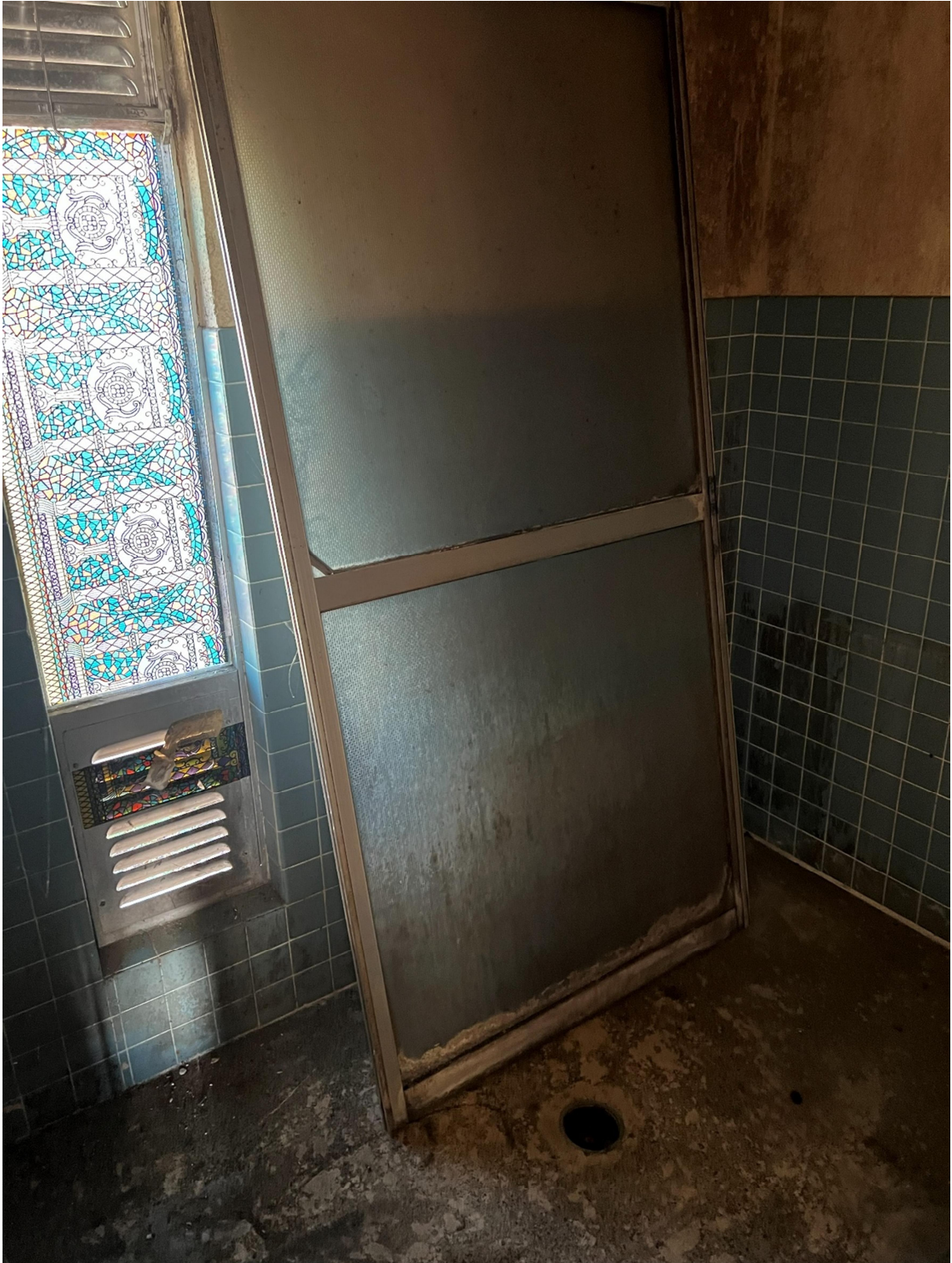
(河和田住宅 (浴槽無・給湯無) の浴室)
