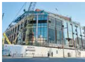
建設中の新市民会館
