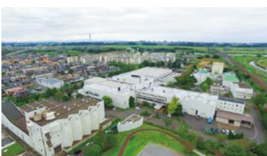
市浄化センター
