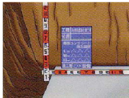
⑧基礎コンクリート 厚み確認 H=〇〇
