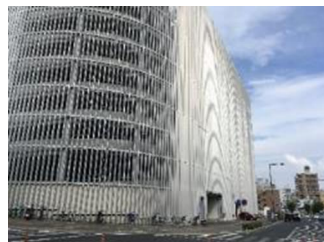
ルーバーによる建物と一体的なデザイン
