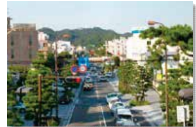
景観地区の事例 「鎌倉景観地区」 歴史的風土や自然景観と調和したまちなみ(出典:国土交通省ホームページ)
