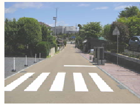
偕楽園御成門通り 左は改修前 右は改修後
