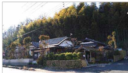
緑の斜面に寄り添う、調和の美（保和苑特定ゾーン周辺） 建物と植栽が織りなす景が、斜面緑地と静かに調和し、自然と共生する穏やかな空間を生み出している。
