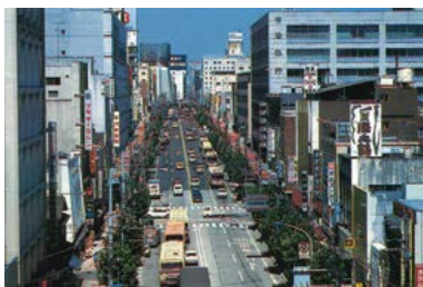
かつての国道50号・南町周辺
