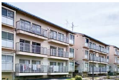
市営見川住宅
