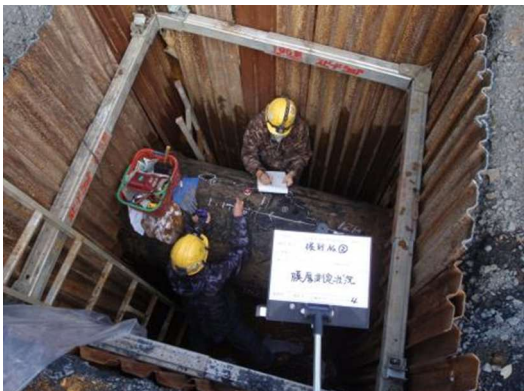
図 4-10 開江系導水管管体調査状況
