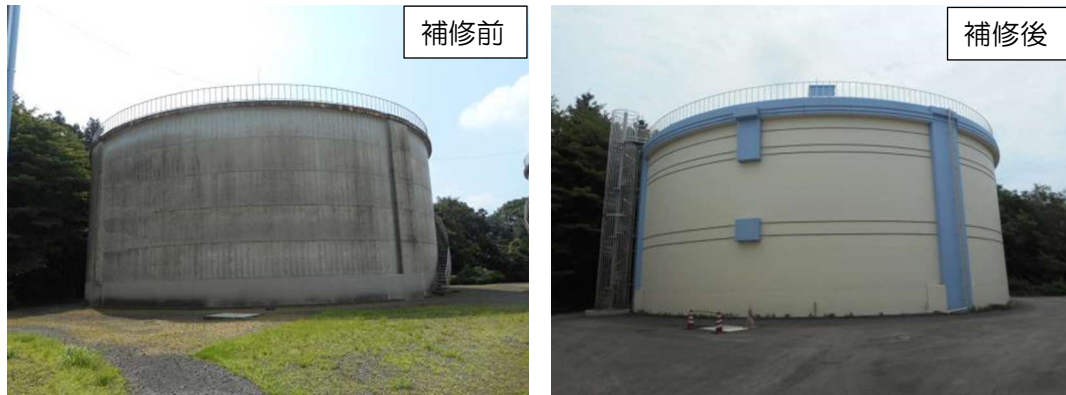
図 4 -9 開江配水池の補修状況
