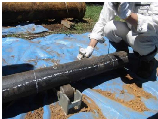
図 3-5 腐食深さ測定状況
