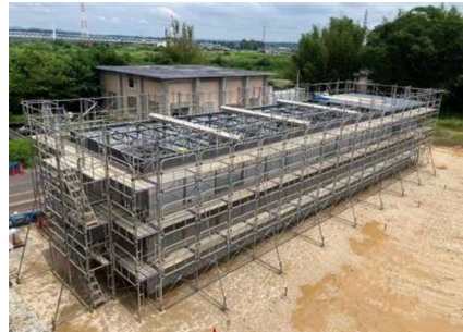
図 4-6 新取水導水施設整備状況（導水ポンプ棟整備）
