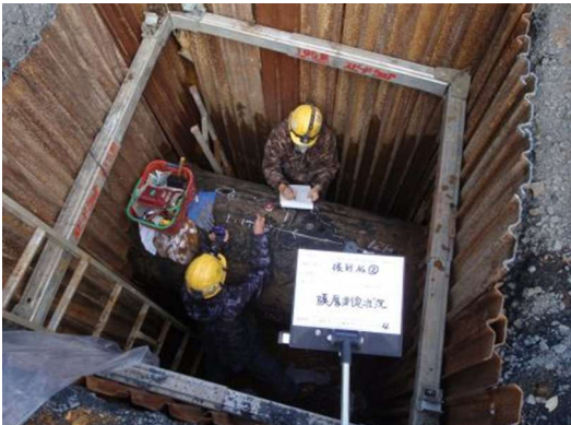
図 4 -10 開江系導水管管体調査状況
