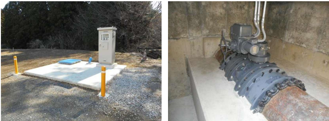
図 4 -17 開江浄水場流量調節弁設置状況
