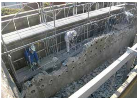
図4-2-4 開江浄水場沈でん池の耐震補強状況（20cm厚の整流壁を30cm厚に再構築）
