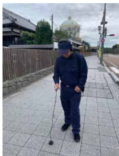
図4-5-4 音聴による漏水調査の様子
