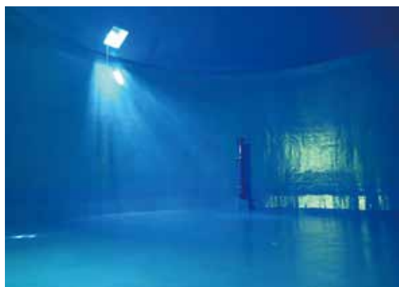
図4-3-7 修繕後の配水池内部
