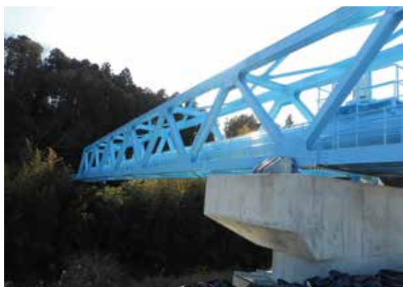
図4-3-6 水管橋（田野川第一水管橋）
