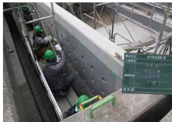
図4-2-4 開江浄水場沈でん池の耐震補強状況（20cm厚の整流壁を30cm厚に再構築）
