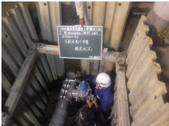
No.1 アイカン・横田JV 配水管布設替工事(第16工区)
