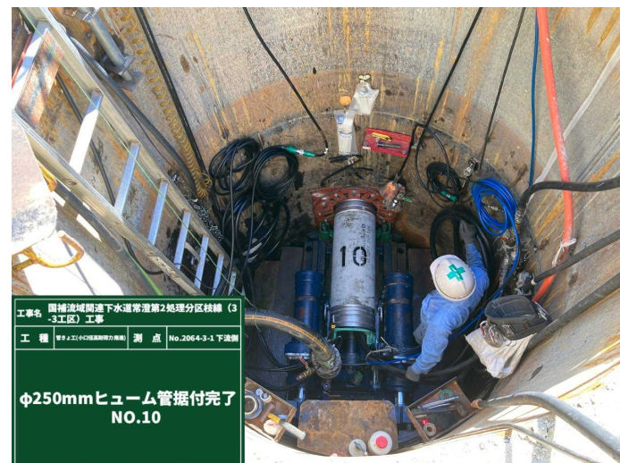
No.10 菅原・平和JV 国補流域関連下水道常澄第2処理分区枝線(3-3工区)工事
