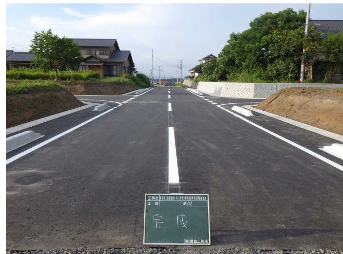
No.16 (株)豊島工務店 東前第二区画道路10-2号外2路線道路改良及び造成工事
