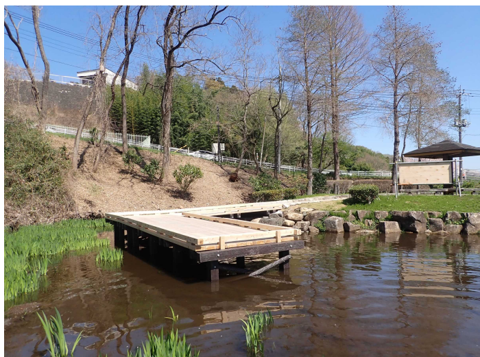
No.11 (株)石翠園 国補逆川緑地あやめ広場木道改築工事
