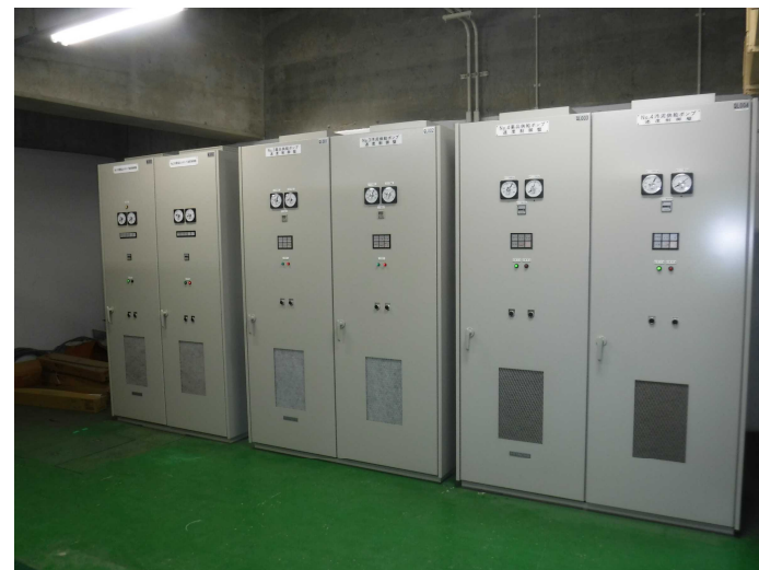
No.4 昱・泰明JV 国補公共下水道水戸市浄化センターNo.3汚泥脱水機外電気設備改築工事
