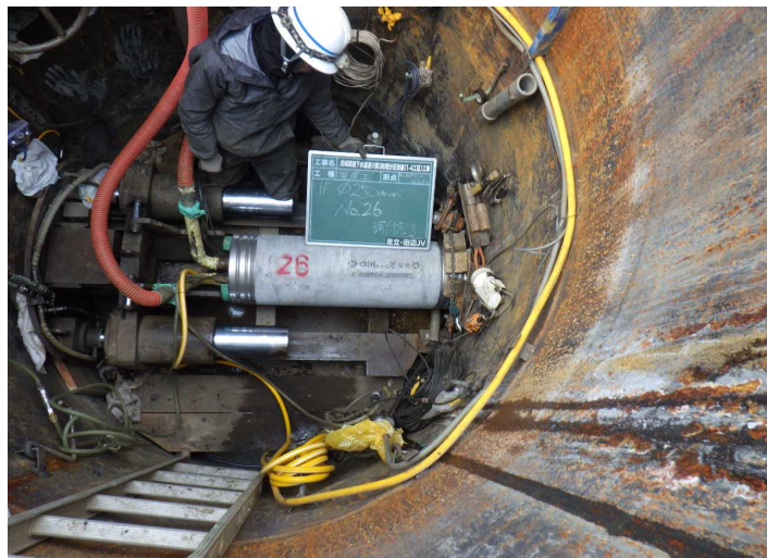
No.5 足立・田辺JV 流域関連下水道逆川第3処理分区枝線(1-4工区)工事
