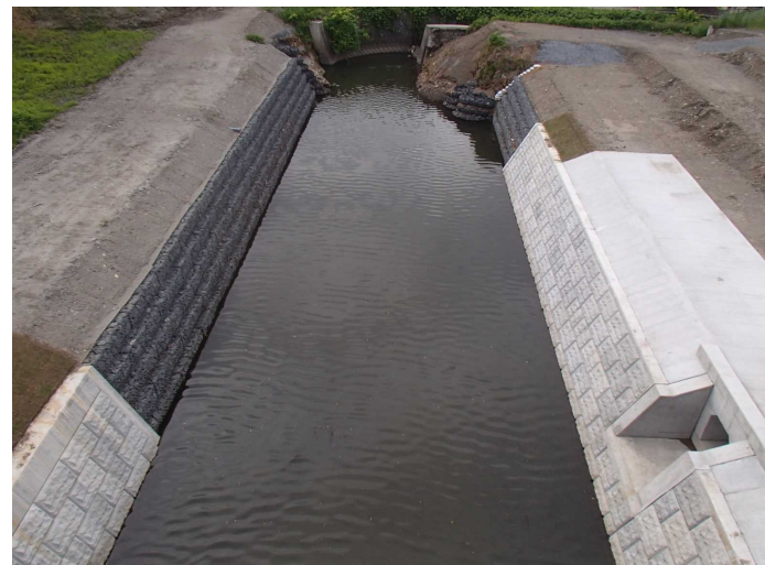
No.6 (株)市毛建設 都市計画道路3・3・2号中大野中河内線(松が丘工区) 沢渡川護岸整備工事
