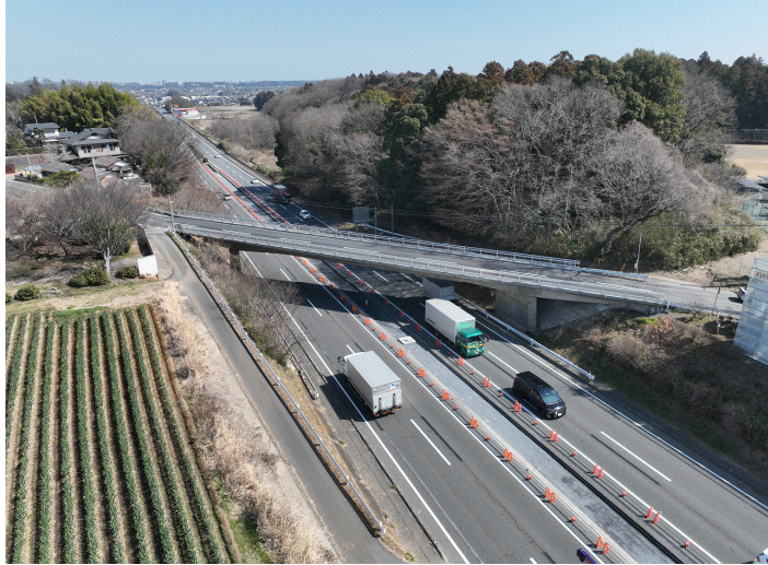
No.13 田口建・海老澤JV 酒門橋橋梁長寿命化修繕工事
