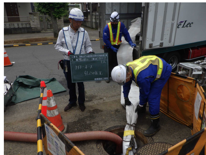
No.12 高橋建設工業(株) 国補公共下水道双葉台処理分区枝線改築工事
