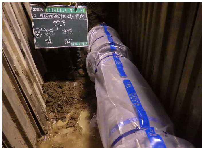
No.7 海老澤・田口建JV 配水管布設替工事(第19工区)
