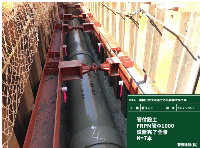
No.9 菅原建設(株) 国補公共下水道三の丸幹線改築工事
