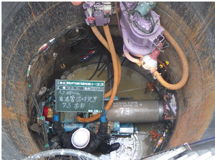
No.15 東洋・三剛JV 国補公共下水道桜川処理分区枝線(3-1工区)工事
