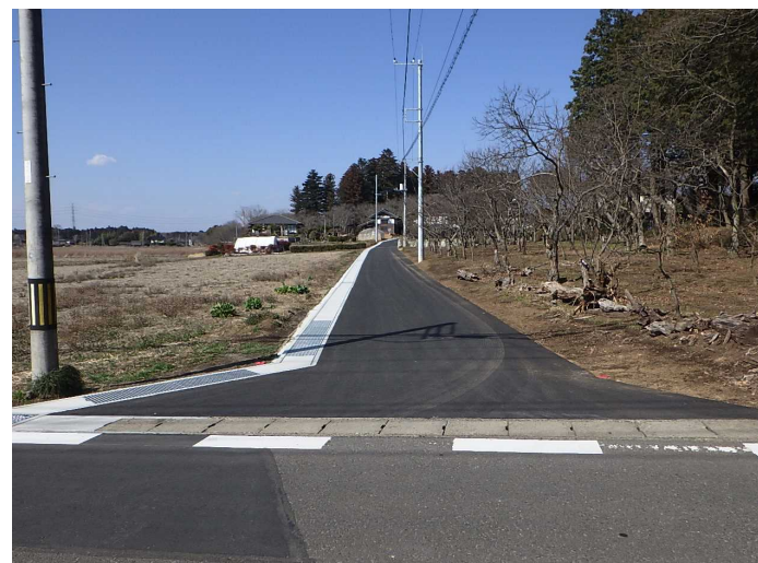
No.8 (株)鯉淵工業 内原8-1031号線狭あい道路整備工事
