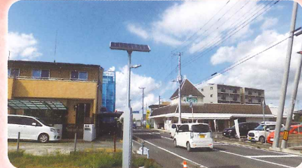
LED防犯灯設置
