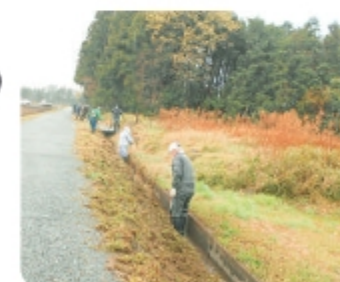
側溝等の清掃
