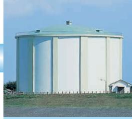
水道水をたくわえて、自然の圧力により市内へ給水します。
