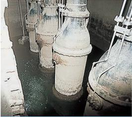
取水塔の中にあります。原水をくみ上げて、ダム導水ポンプ場へ送ります。
