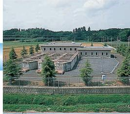
送られてきた原水は、沈砂池で砂や土がしずめられ、導水ポンプで楮川ダムへ送られます。
