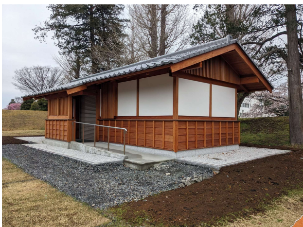
①公衆トイレ新設工事
