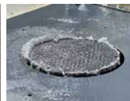
図2 マンホール蓋が外れない実験の様子
