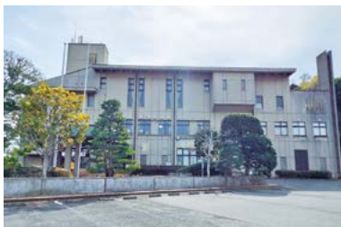
改修予定の常澄庁舎
