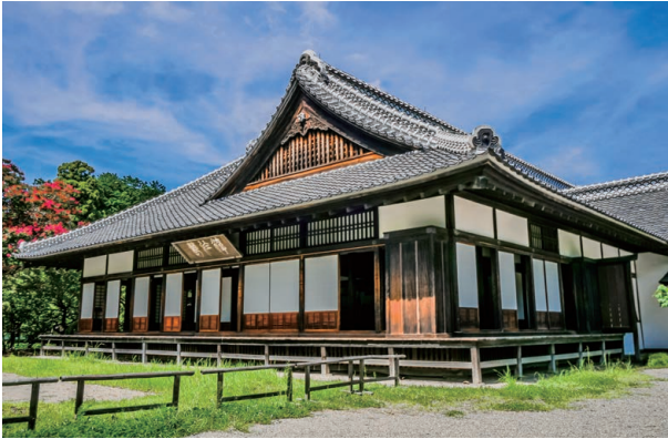
弘道館（茨城県水戸市／国特別史跡）
