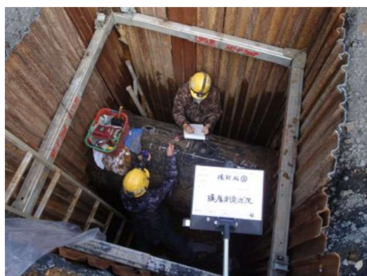
図 4-10 開江系導水管管体調査状況
