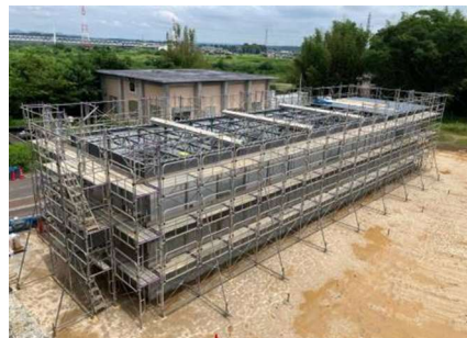
図 4-6 新取水導水施設整備状況（導水ポンプ棟整備）
