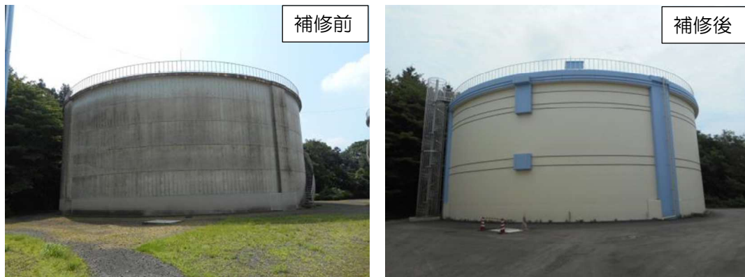
図 4-9 開江配水池の補修状況
