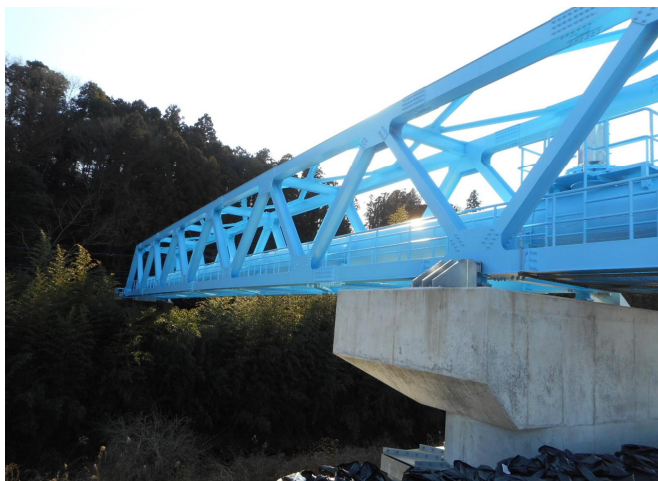
図 4-3-6 水管橋（田野川第一水管橋）
