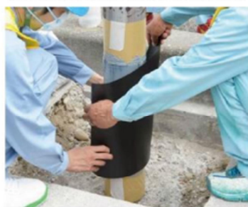
4. CFRTPシート（多層）の貼り付け
