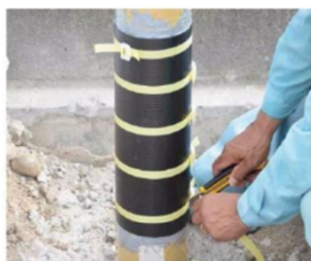
5. CFRTPシートの養生
