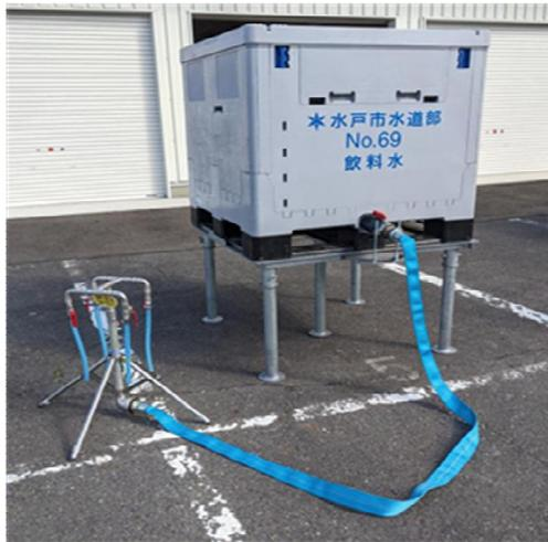
図 4-3-3 応急給水用給水タンク
