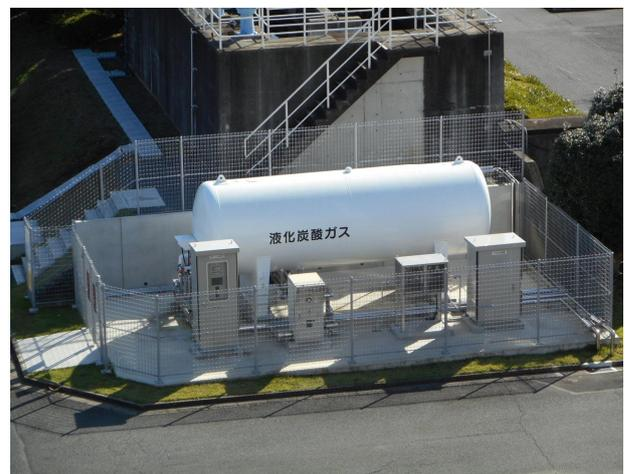
図 4-1-3 炭酸ガス注入設備（楮川浄水場）
