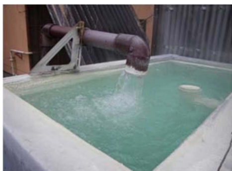
図 2 落下式ばっ気槽
