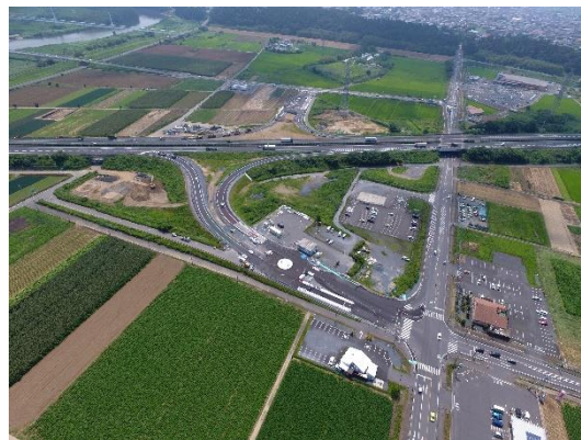
写真：水戸北スマートインターチェンジ
