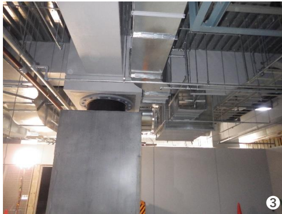
写真：①市役所防災設備 ヘリポート／②市役所防災設備 耐震性貯水槽（施工時）／③市役所防災設備 免震ゴム
