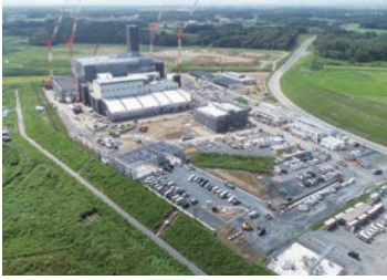
4月から稼働する新清掃工場
