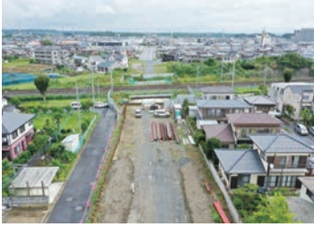
整備が進む赤塚駅西線
