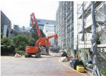
解体工事が進む新市民会館建設用地
