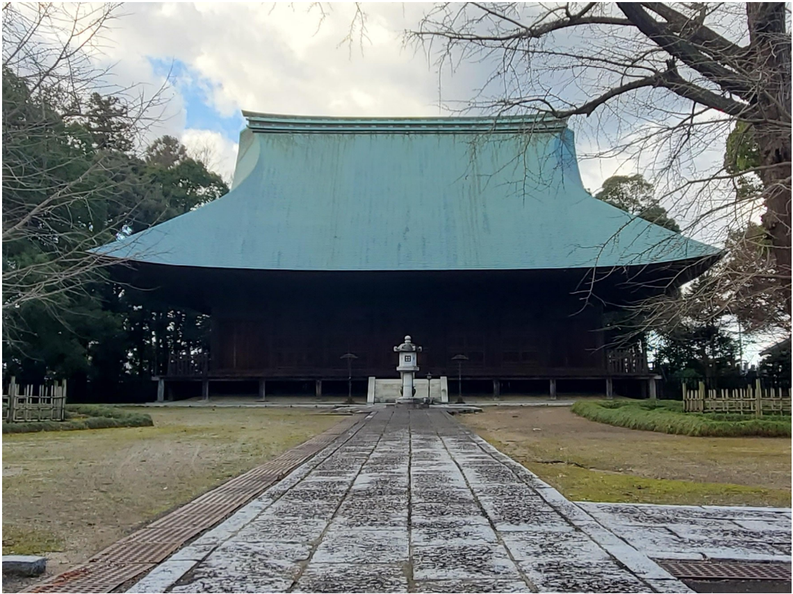
修理前（令和 2 年 1 月）
