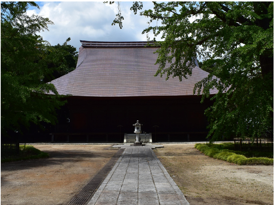
修理後（令和 6 年 8 月）
