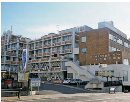
老朽化が進む水戸協同病院
