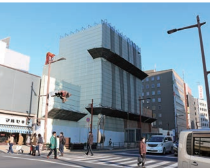
新市民会館建設予定地(泉町1丁目)
