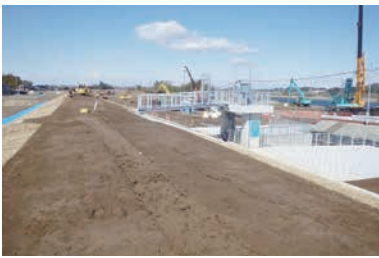
築堤工事(坏大野地内)
