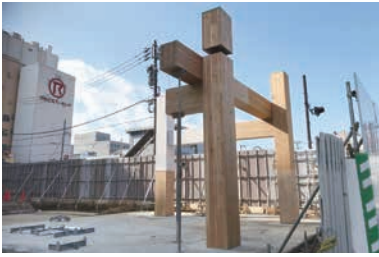
解体現場の木の柱
