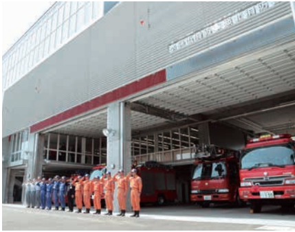
消防本部北消防署
