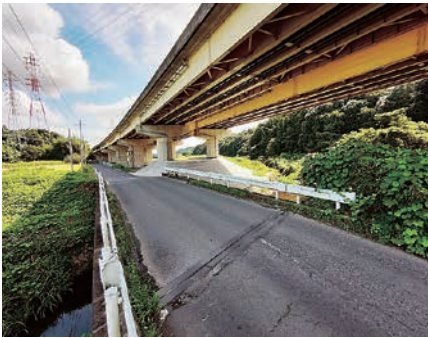
市道渡里209号線 下田橋付近
