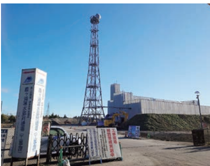
霞ヶ浦導水那珂機場の工事現場
