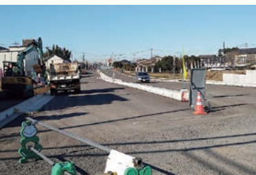
早期完成に向け整備が進む酒門工区
